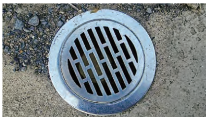
図10 シークエンスの構成 排水口の外観 接写3 (撮影：櫻井 宏哉)
