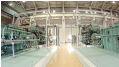
図12 シークエンスの構成 水流を生み出す施設と水路：巨椋池排水機場（撮影：櫻井 宏哉）
