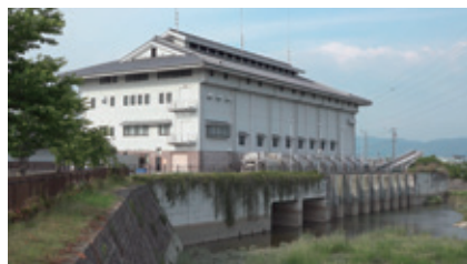
図3 撮影場所：巨椋池排水機場 (撮影：櫻井 宏哉)
