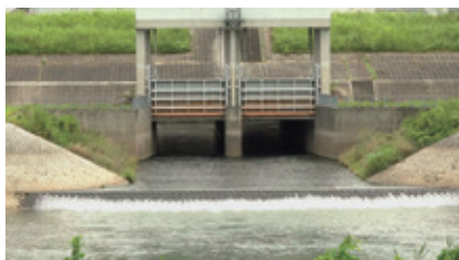
図4 撮影場所：巨椋池排水機場 (撮影：櫻井 宏哉)
